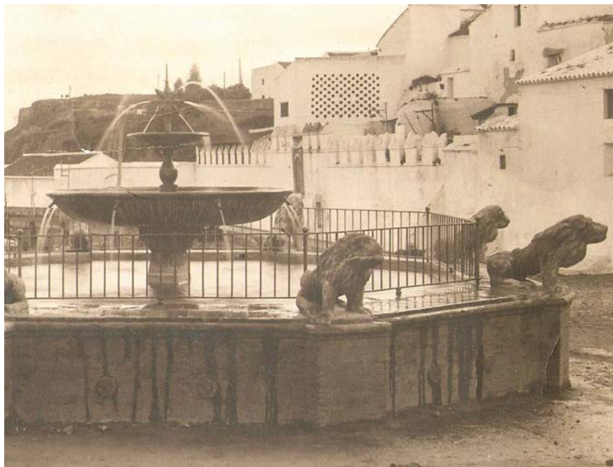
La vieja fuente se convirtió en un elemento meramente decorativo, se cerraron sus 16 caños y se le colocó una gran taza de hierro fundido rematada en una estrella de 8 puntas por las que brotaba el agua
